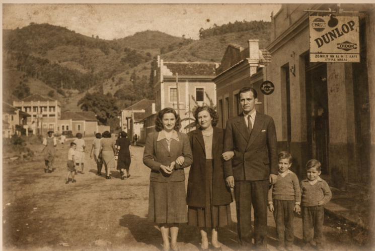
Comércio de Dayer & Filhos à Rua Cel. Pedro João (Entre Morros) Foto: Acervo da autora
